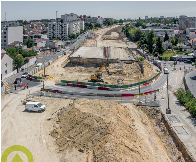
Avancée du chantier en direction de Montreuil – Juillet 2020
