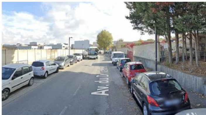
l'av du Docteur Vaillant, au niveau de la voie logistique Paddock
