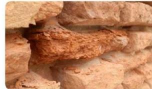
Brique effritée, inapte au réemploi
