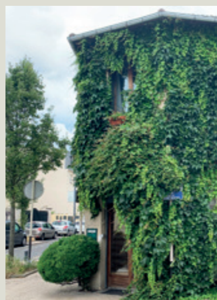
Maison aux vignes vierges, rue Alexandre Dumas.
